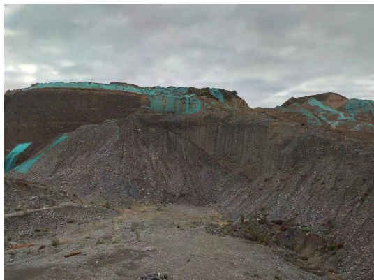
照片 1-2 矿区遗留开采斜坡 2
