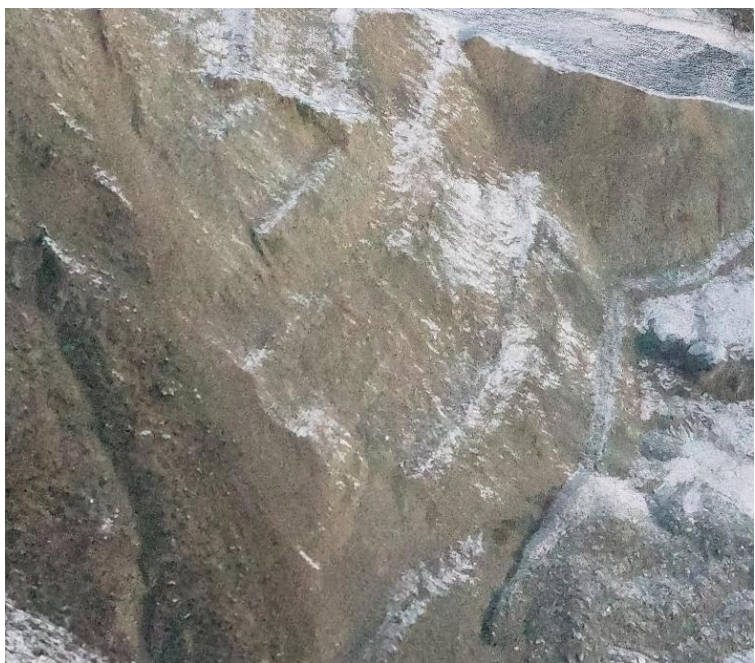
照片 3-1 现状不稳定斜坡
